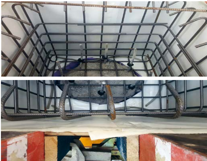
Bild 3 Einbindung eines Pfahlkopfanschlusses mit Hybridabdichtungssystem adicon® AVS
