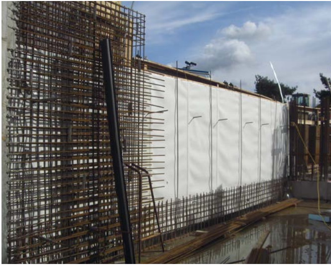
Bild 2 Hybridabdichtungssystem adicon® AVS auf der Wandschalung
