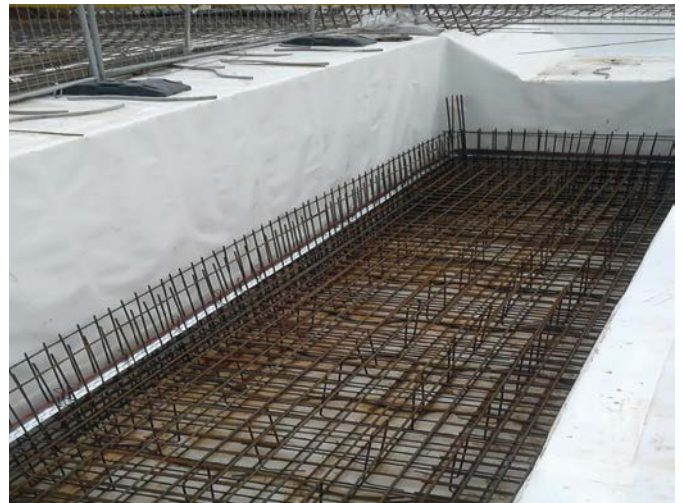
Bild 1 Bewehrung der Bodenplatte nach der Verlegung des Hybridabdichtungssystem adicon® AVS
