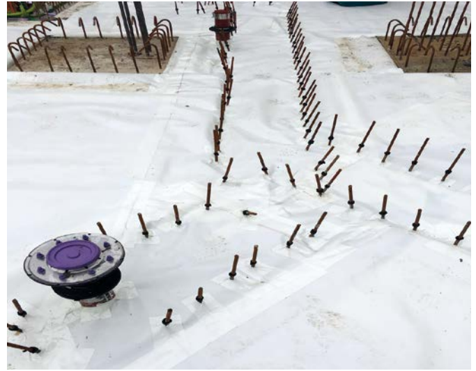
Bild 4 Hybridabdichtungssystem adicon® AVS – Durchdringung Fundament/Bewehrung
