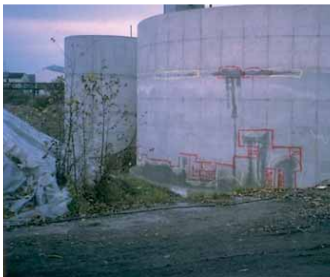
Bild 1 Klassische „Weiße Wanne“ nach [1] und [3], Selbstheilungseffekt/Bild [1] bei Probefüllung der Behälter
