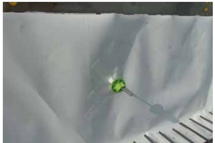
Einbindung Potenzialanschluss in die adicon® AVS Verbundfolie
