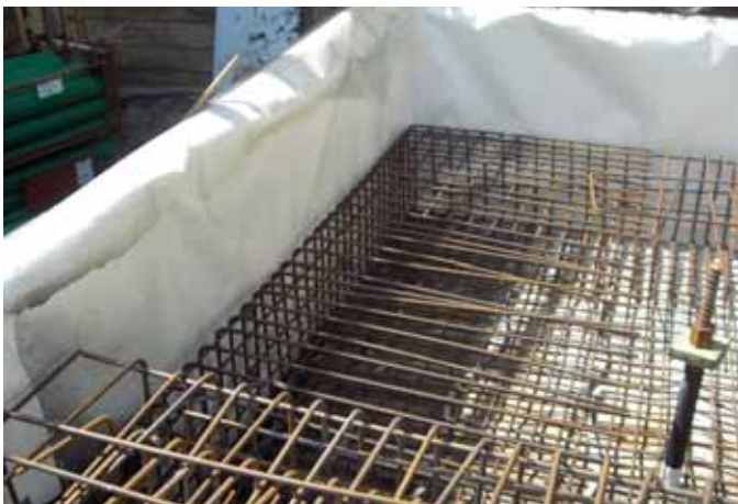
adicon® AVS an der Bodenplattenstirnseite hochgezogen, Anschluss für nachfolgende Außenwände
