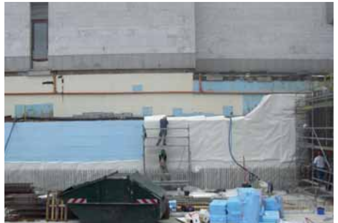
adicon® AVS Verbundfolie auf der Wärmedämmung, einseitig geschalte Wandfläche
