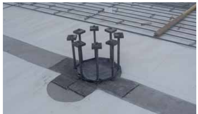
Einbindung eines Bohrpfahls in die adicon® AVS Abdichtung
