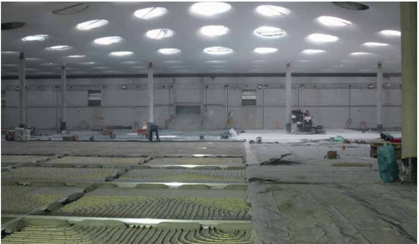
adicon® AVS unter der Bodenplatte mit Bodenaufbauten und Bauteilaktivierung, WU-Konstruktion mit Nutzungsklasse A 0 bis A ***
