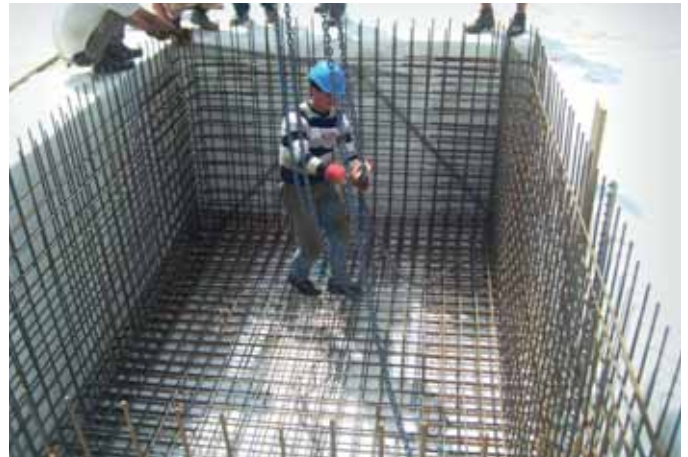
Bewehrung Aufzugsunterfahrt mit adicon® AVS
