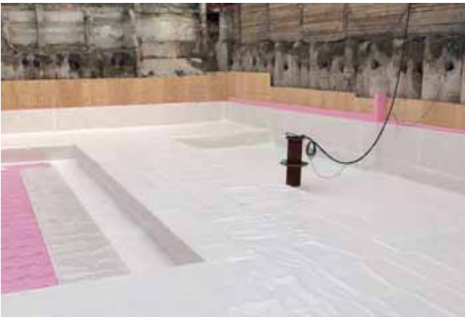
Anschluss der adicon® AVS Verbundfolie an einen Brunnenkopf
