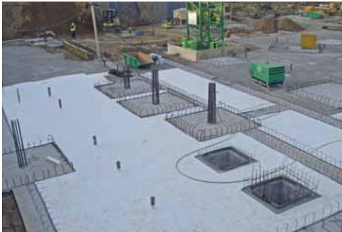
Verlegung adicon® AVS in Teilflächen (nutzungsbedingt)
