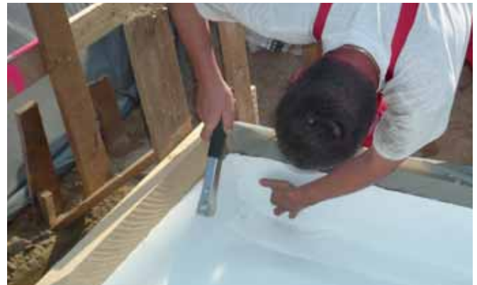
Eckausbildung Bodenplatte Stirnseite
