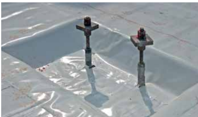
Einbindung des adicon® AVS an Zuganker und Höhenversprungen der Bodenplatte
