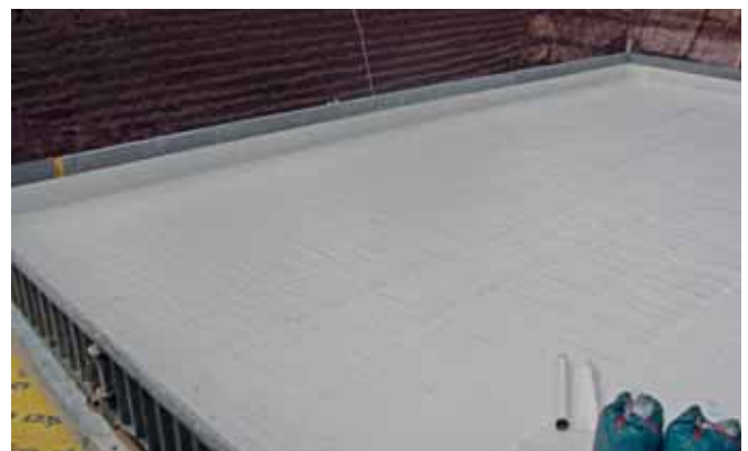
Fertig verlegte adicon® AVS Abdichtung auf Sauberkeitsschicht Bodenplatte Stirnseite
