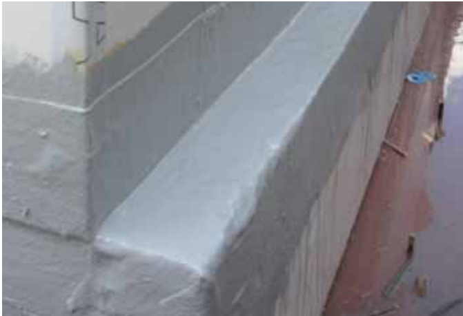
Im Anschlussbereich Bodenplatte/Wand ergänzende oberseitige Versatzabdichtung mit adicon® lamin DS
