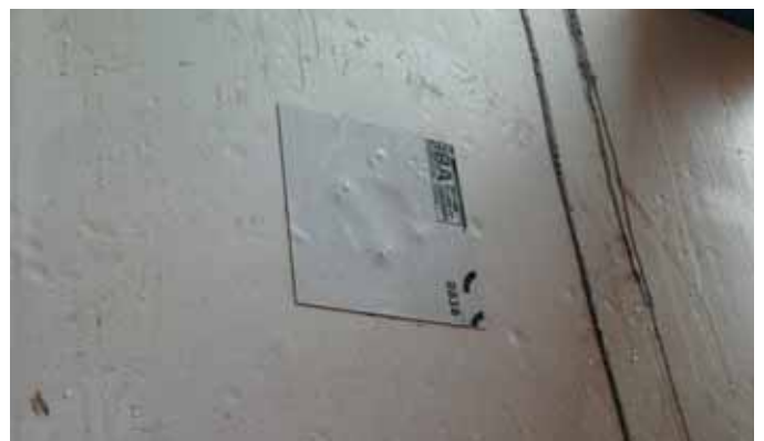
Nachträgliches Überarbeiten der Wandabspannung mit adicon® AVS Tape
