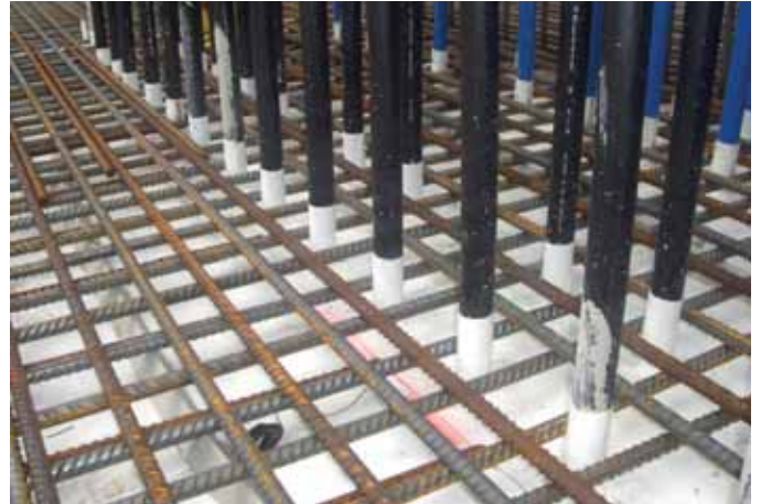
Durchdringungen der adicon® AVS Verbundfolie von Geothermieleitungen
