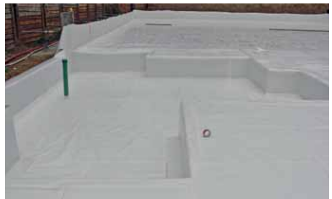
adicon® AVS Abdichtungsbahn mit Höhenversätzen der Bodenplatte
