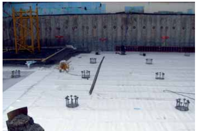
Verlegung der adicon® AVS Verbundfolie auf der Sauberkeitsschicht mit integrierten Bohrpfählen
