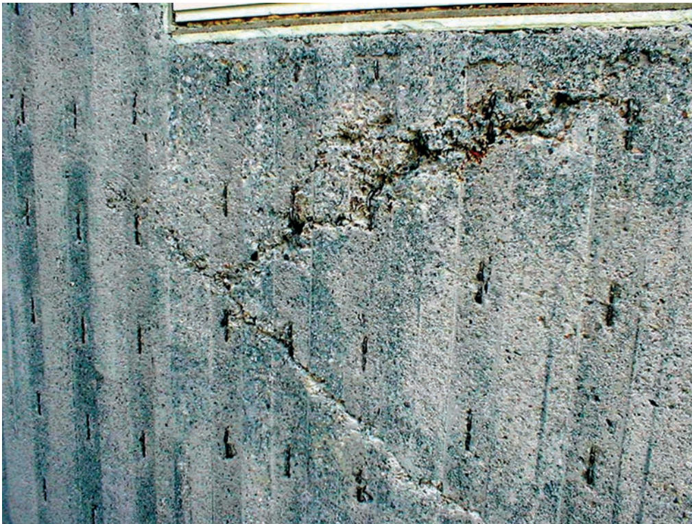
Bild 4. Beton-Verdichtungsbild im Fensterbereich
