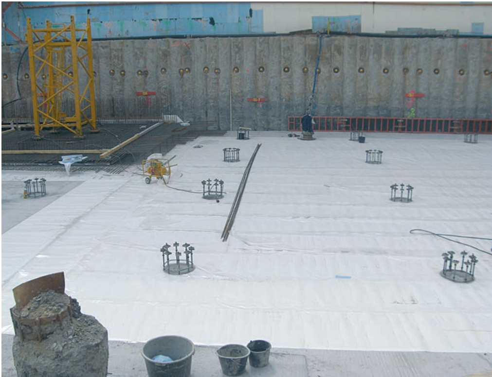
Bild 2. adicon® AVS System auf Sauberkeitsschicht (Frankfurt/M.: Städel)
