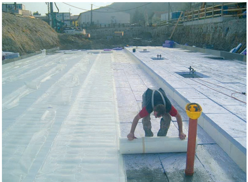
Bild 3. Verlegung von adicon® AVS Abdichtungsverbundbahn auf Wärmedämmung unter der WU-Bodenplatte
