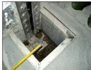
Fugenband- Klemm- konstruktion
