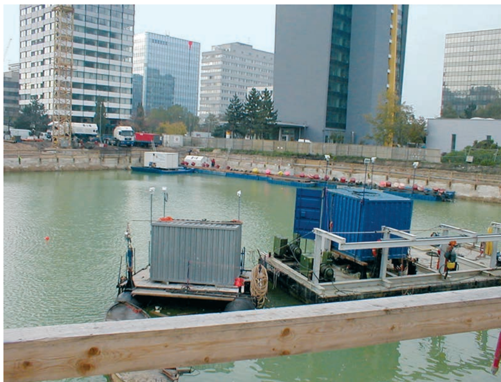
Bild 1. Geflutete Baugrube mit Grundwasserstand
