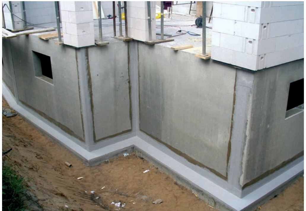
Bild 5. Streifenabdichtung von Element-Fertigteilwänden mit Flüssigkunststoff adicon® lamin DS (Fotos: adicon)
