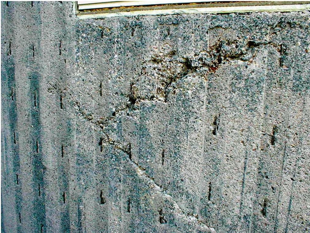
**Bild 4.** Beton-Verdichtungs bild im Fensterbereich
