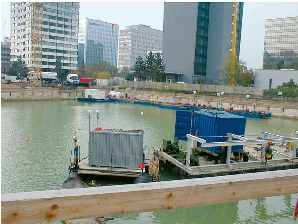
Bild 1. Geflutete Baugrube mit Grundwasserstand
