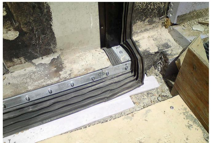
**Bild 8.** Außenseitiges Klemmfugenband aus Nitrilkautschuk
