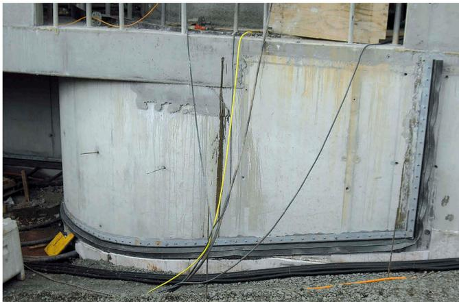
**Bild 7.** Innenliegendes Klemmfugenband aus Nitrilkautschuk, Montage mit Polymerquellpaste
