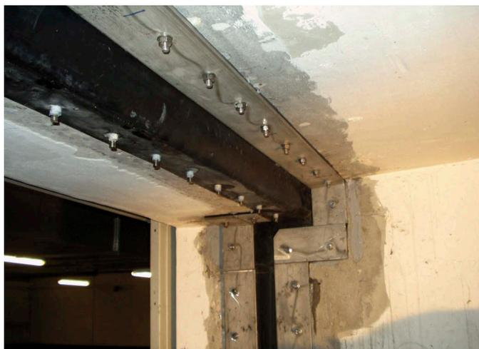
**Bild 4.** Doppelseitige Fugenband-Klemmkonstruktion aus Elastomer mit Edelstahlklemmung
