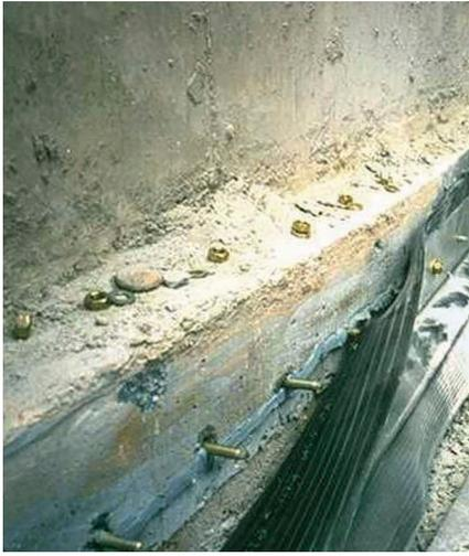
**Bild 10.** Innenliegendes Klemmfugenband aus Nitrilkautschuk, Montage mit Polymerquellpaste
