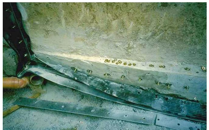
**Bild 9.** Innenliegendes Klemmfugenband, Setzen der Ankerstäbe
