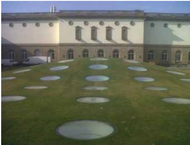
Bild 2 Stadel Museum Frankfurt/M.: Hochwertig genutzte Untergeschosse
