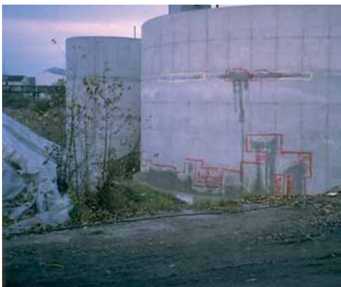
Bild 1 Klassische „Weiße Wanne“ nach [1] und [3], Selbstheilungseffekt/Bild [1] bei Probefüllung der Behälter
