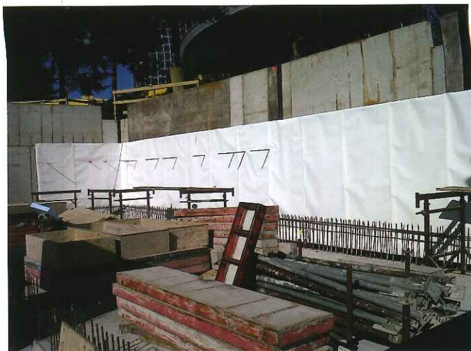
Bild 2 Zweiseitig geschaltete Wände mit Hybridabdichtungssystem adicon® AVS
