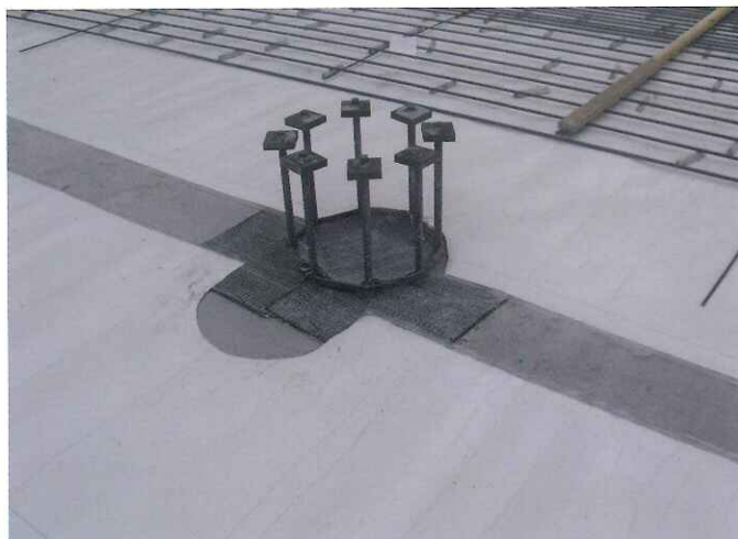
Bild 3 Einbindung von Bohrpfeilen mit Hybridabdichtungssystem adicon® AVS
