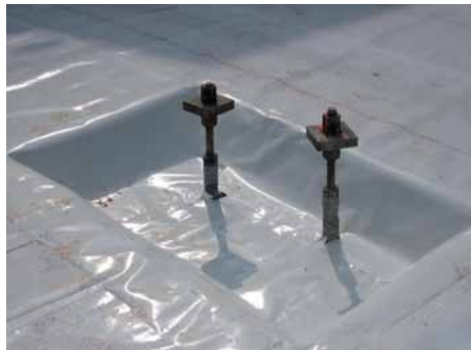
Bild 3 Einbindung von Zugpfählen nach DIN 18195 – nicht möglich
