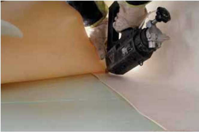
Bild 6 Bei Temperaturen unter 5° C nach DIN 18195 – nicht möglich (aufwendige Heißklebe-Verfahren gem. Verarbeitungsrichtlinie erforderlich)
