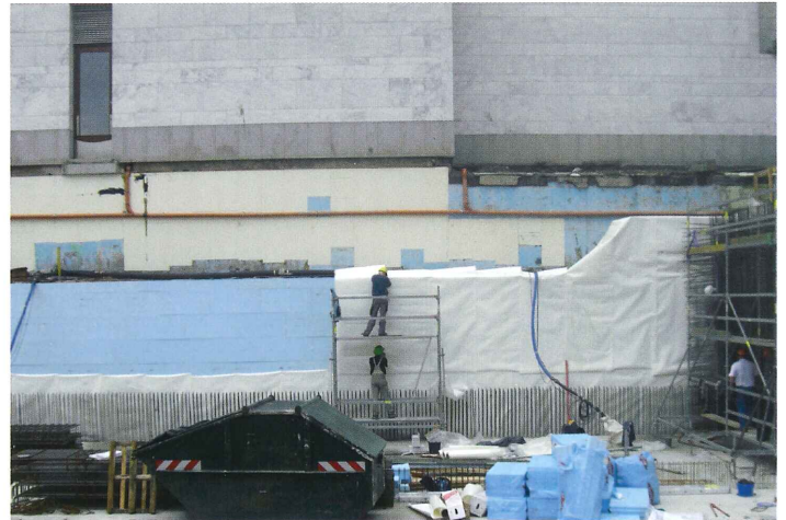
adicon® AVS Verbundfolie auf der Wärmedämmung, einseitig geschaltete Wandfläche
