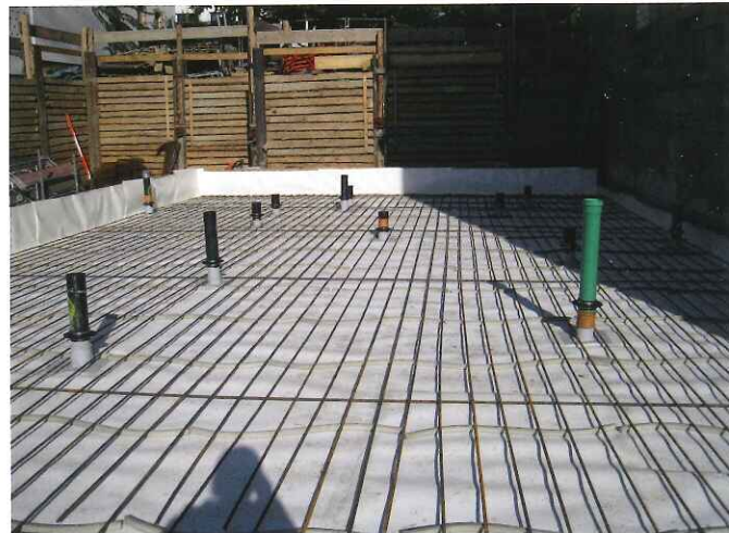
Bild 5 Einbindung von Bodeneinläufen mit Hybridabdichtungssystem adicon® AVS
