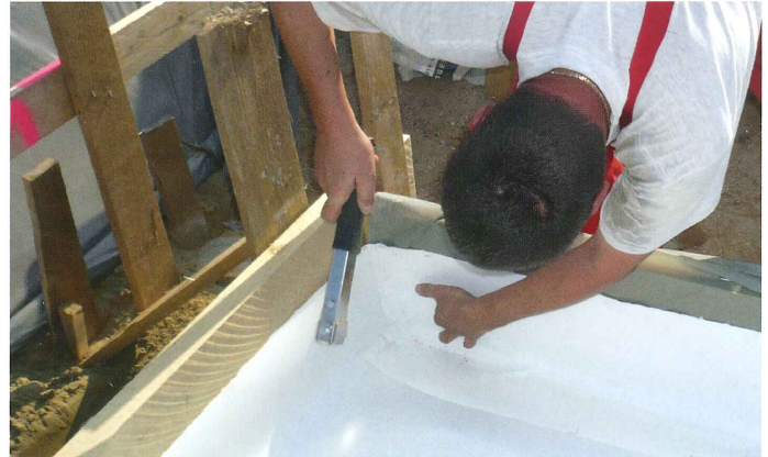
Eckausbildung Bodenplatte Stirnseite
