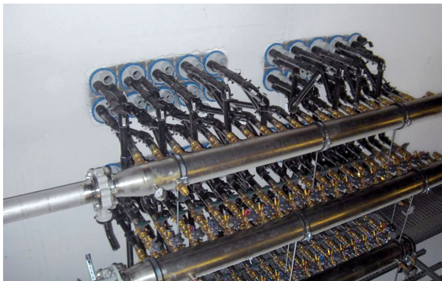
Bild 12 Druckwasserdichte Kabeleinführung
