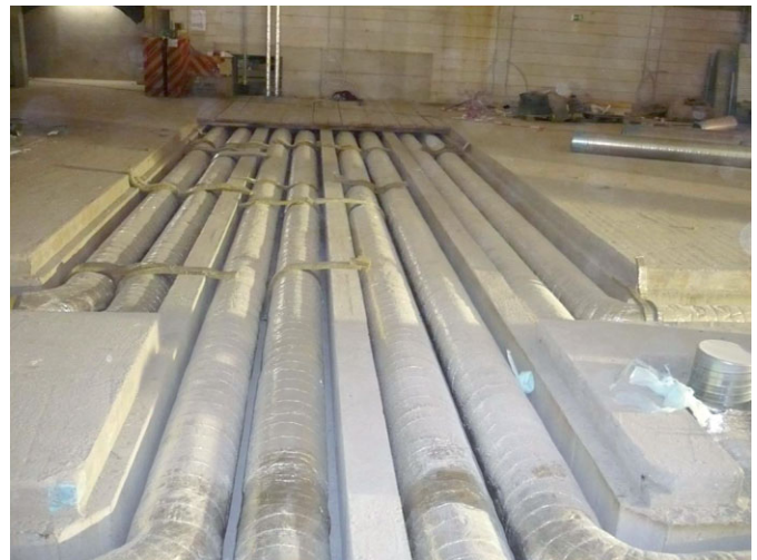
Bild 8 Lüftungsanlage in die Bodenplatte integriert
