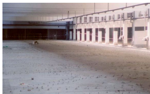
Bild 5 Rissverpressung einer Tiefgarage in München
