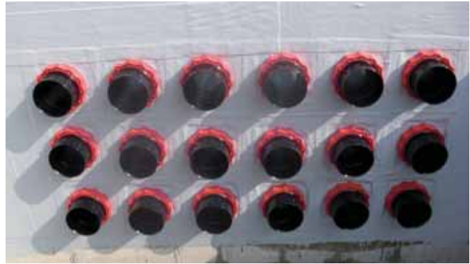
Bild 7 Mehrspartenkabelanschluss Einbindung nach DIN 18195 – nicht möglich
