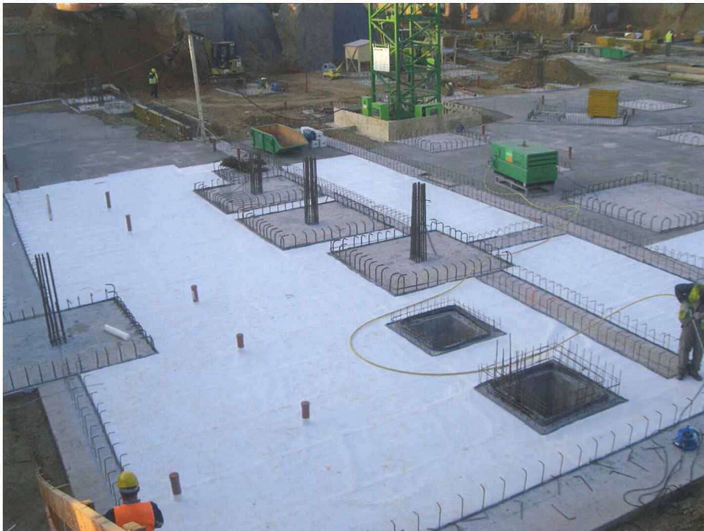
Bild 6 Ausführung von Teilflächen mit Hybridabdichtungssystem adicon® AVS
