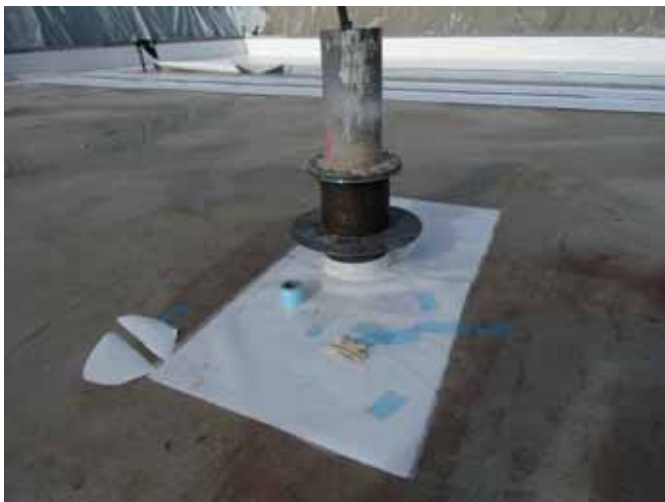
Bild 2 Einbindung von Brunnentöpfen nach DIN 18195 – nicht möglich
