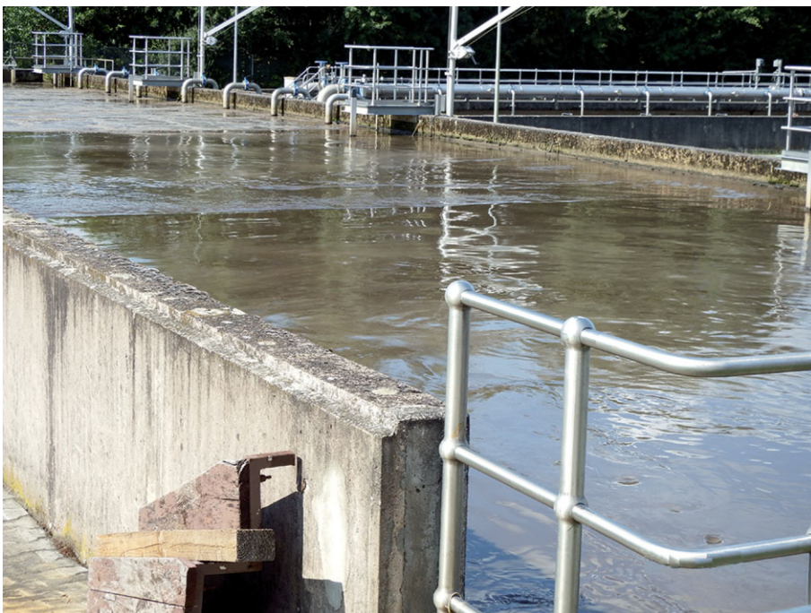
Bild 2 Belebungsbecken, klassische „weiße Wanne“ mit max. Wasserbelastung
