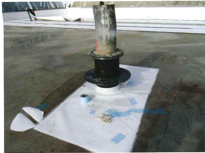
Bild 4 Einbindung von Brunnentöpfen mit Hybridabdichtungssystem adicon® AVS
