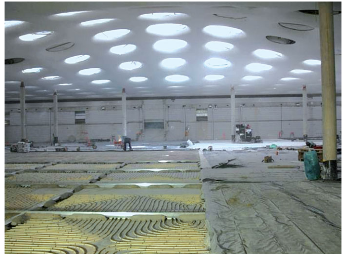
Bild 7 Terrazzoestrich auf Dämmlagen mit Bauteilaktivierung
