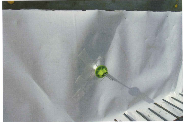
Einbindung Potenzialanschluss in die adicon® AVS Verbundfolie
