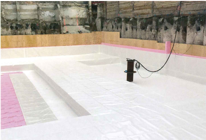
Anschluss der adicon® AVS Verbundfolie an einen Brunnentopf
