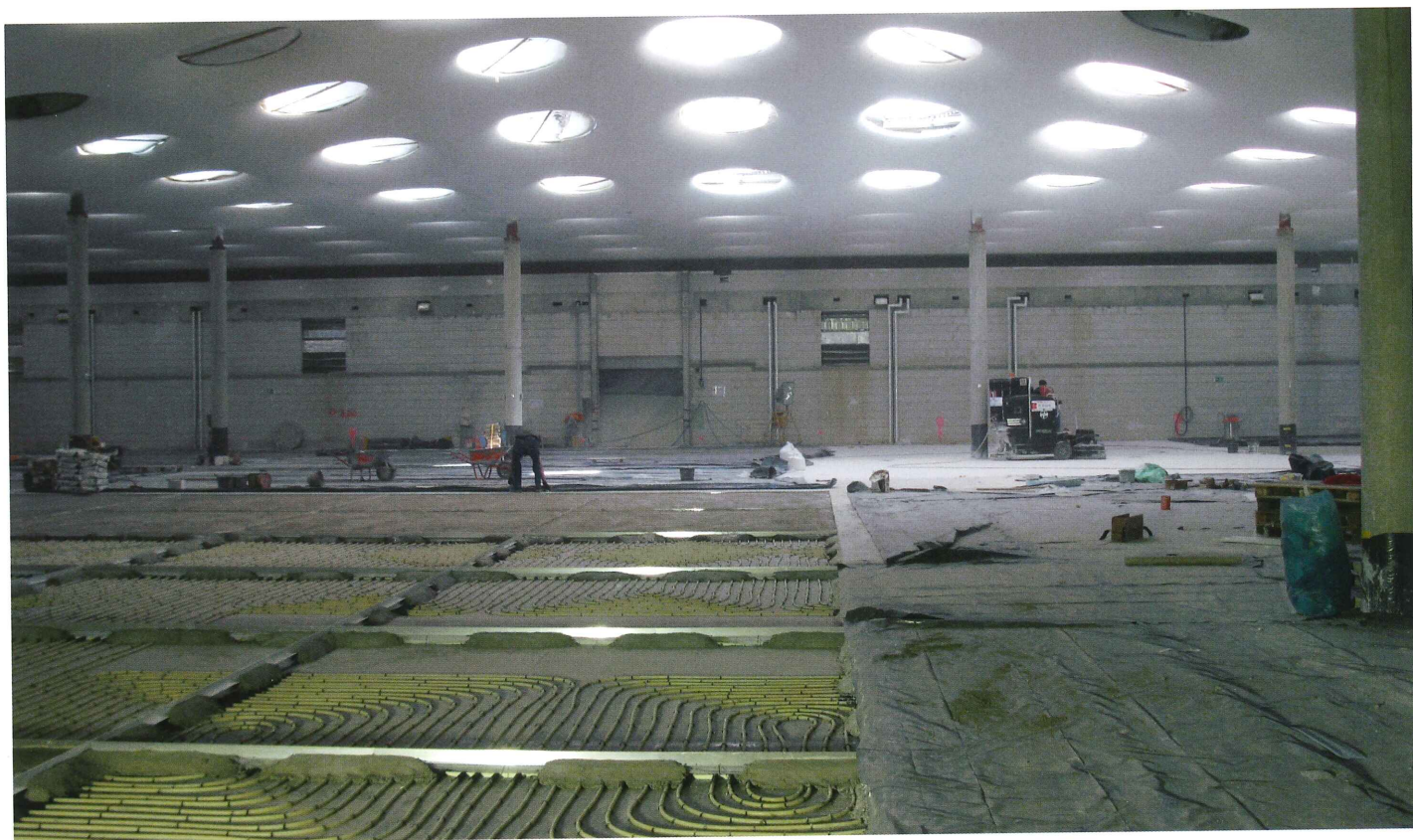
adicon® AVS unter der Bodenplatte mit Bodenaufbauten und Bauteilaktivierung, WU-Konstruktion mit Nutzungsklasse A 0 bis A ***
