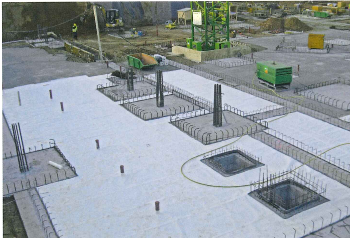
Verlegung adicon® AVS in Teilflächen (nutzungsbedingt)
