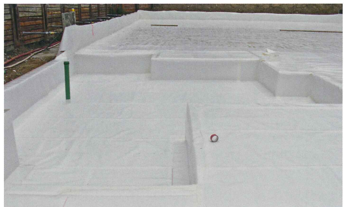
adicon® AVS Abdichtungsbahn mit Höhenversätzen der Bodenplatte
