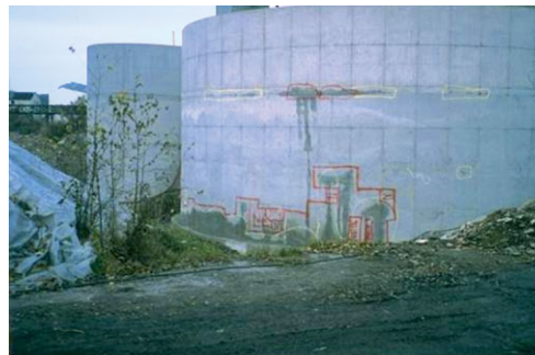
Bild 3 Dichtigkeitsprüfung mit Rissverpressung
