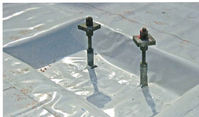
Einbindung des adicon® AVS an Zuganker und Höhenversprungen der Bodenplatte
