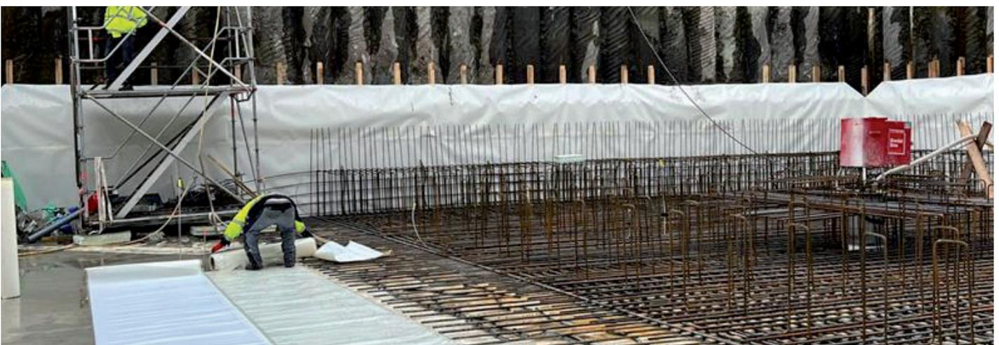
Verlegung adicon® AVS auf Bodenplatte und Wänden
