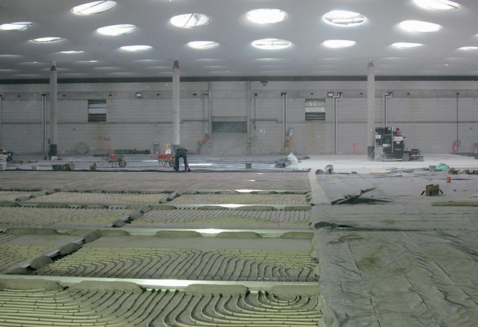
adicon® AVS unter der Bodenplatte mit Bodenaufbauten und Bauteilaktivierung, WU-Konstruktion mit Nutzungsklasse A<sup>0</sup> bis A<sup>\*\*\*</sup>
