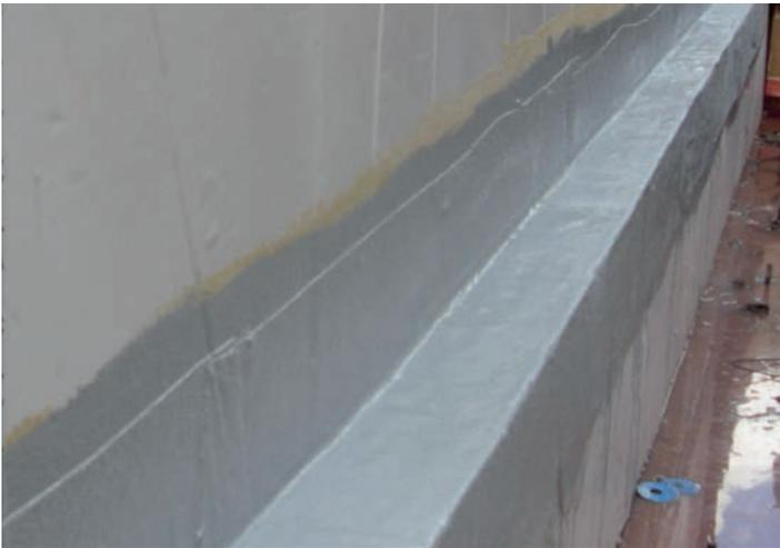
Im Anschlussbereich Bodenplatte/Wand ergänzende oberseitige Versatzabdichtung mit adicon® lamin DS
