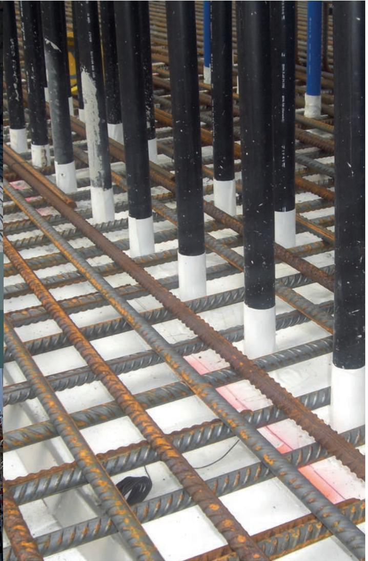
Einbinden von Bodeneinläufen und Geothermieleitungen in die adicon® AVS Abdichtung
