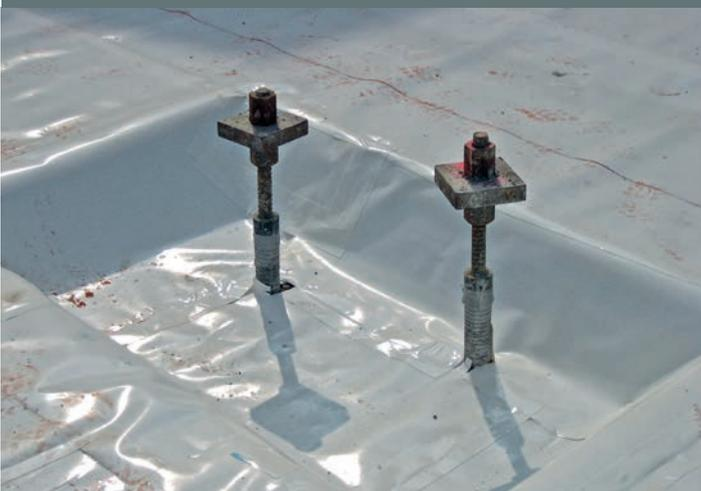
Einbindung der adicon® AVS an Zuganker und Höhenversprünge der Bodenplatte
