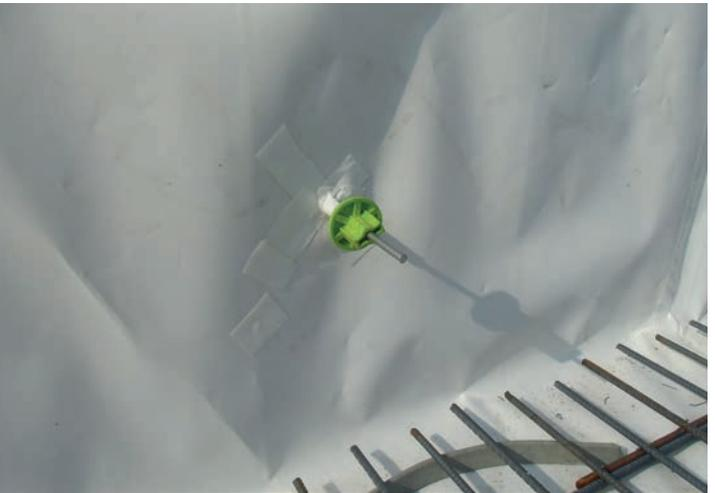
Einbindung Potenzialanschluss in die adicon® AVS Verbundfolie
