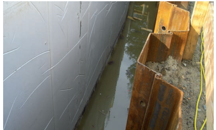
Frankfurt, Pumpstation ca. 530 m 2 adicon® AVS Verbundfolie unter der Bodenplatte ca. 750 m 2 adicon® AVS Verbundfolie an den Wänden
