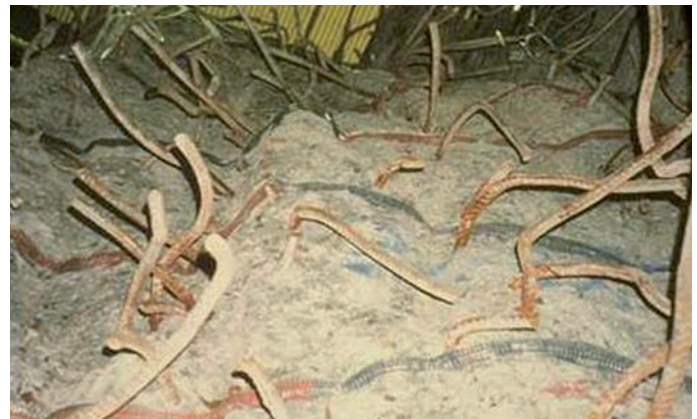
Der adicon®-tec-Injektionsschlauch ist auch zur Fugenabdichtung bei rauhen und unebenen Oberflächen einsetzbar
